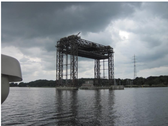
Stuk van de opgeblazen hefbrug
