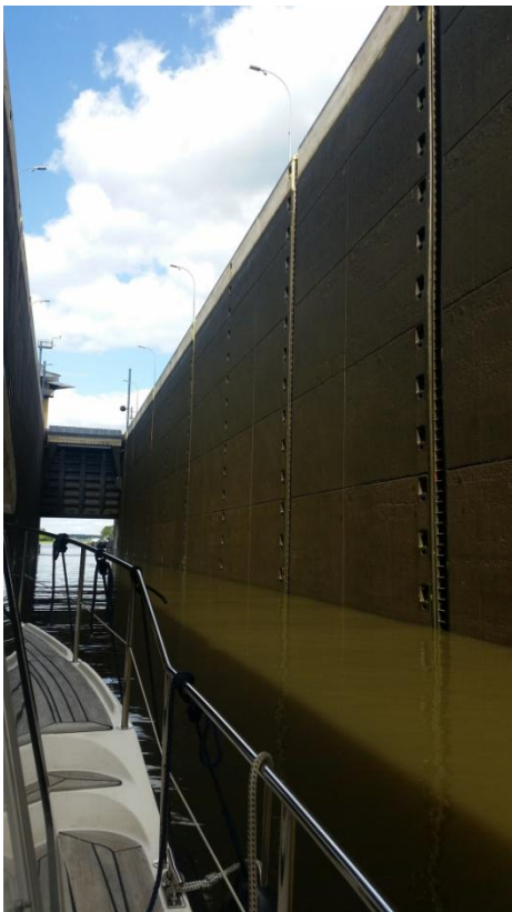
Sluis Hohenwarthe 19,7 meter verval
