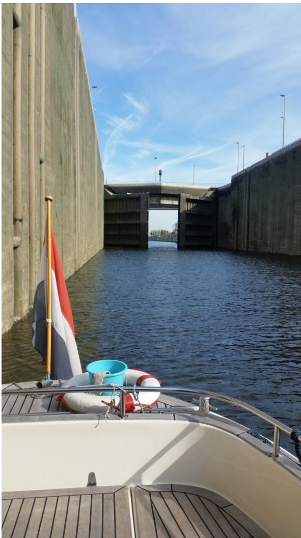
Sluis Lanaye 15 meter omhoog
